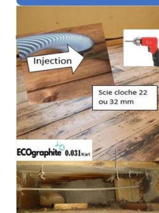
MESURE EPAISSEUR LAME D'AIR L x l X ép. S'il n'y a pas possibilité de voir en périphérie Ou avec un foret long et fin, faire quelques sondages par le haut ou le bas En profiter pour mesurer l'entraxe entre lambourdes L'injection se fera à chaque extrémités des lambourdes R=3 en 10 cm épaisseur
